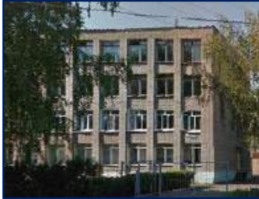
Ремонтные работы в МБОУ «Гимназия № 6 им. Габдуллы Тукая» (г. Ижевск)
